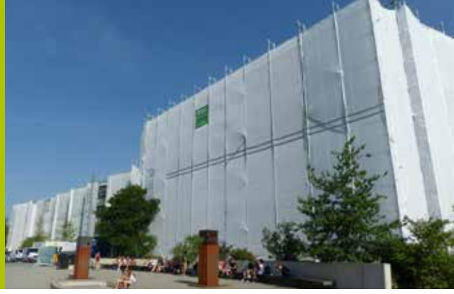
Ein Werk von Christo? Eingerüstung während der Außenrenovierung.
